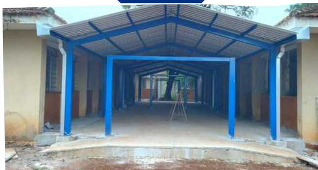
IMAGENS DA OBRA EM EXECUÇÃO
